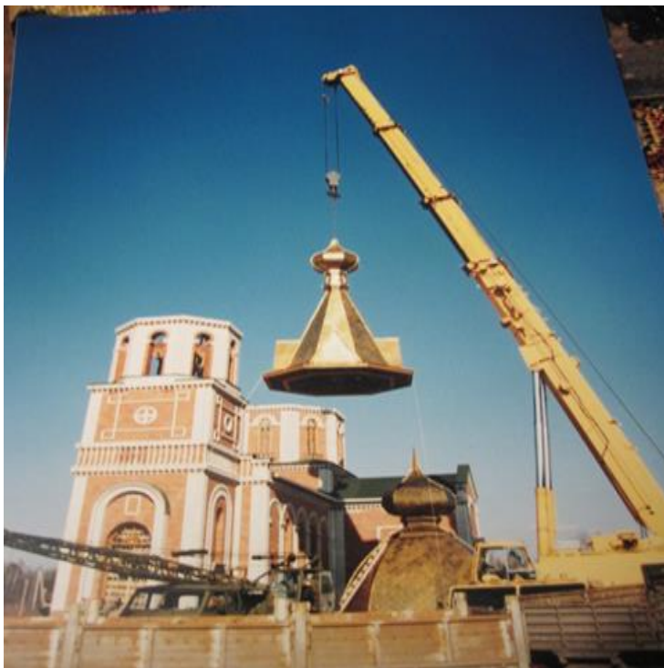
Будівництво храму Архистратига Михаїла
